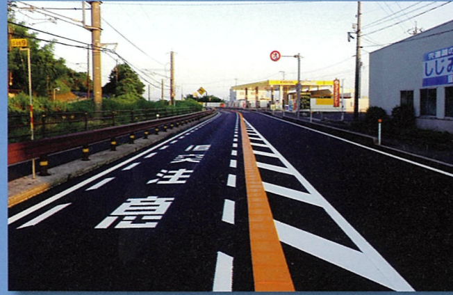
国道9号穴道地区(松江市)
