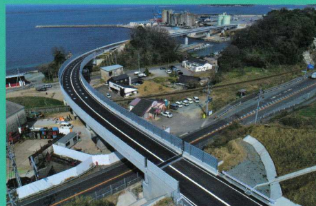
浜田港福井地区臨港道路(浜田市)
