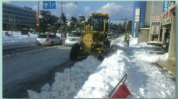
懸命の除雪作業で生活路線を守る
