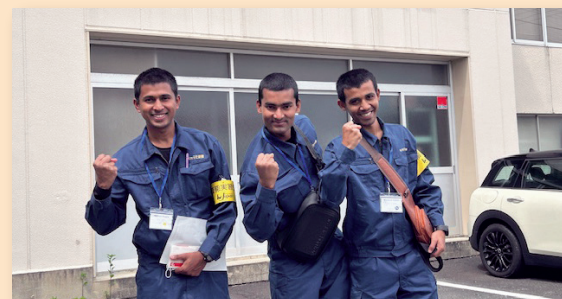
建設業で活躍する外国人技能者
