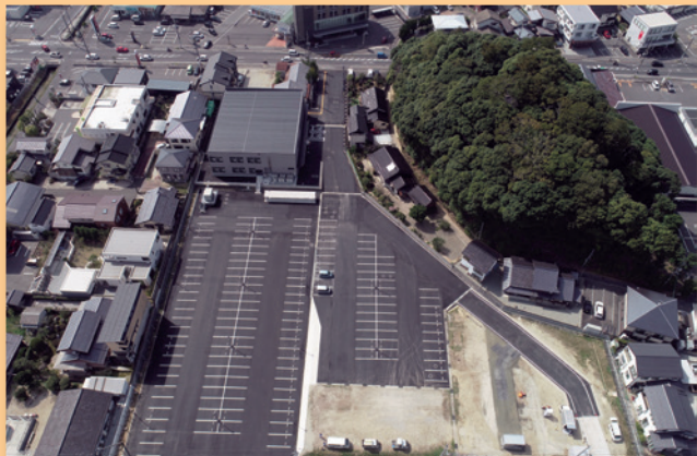
県庁第四庁舎(松江市)
